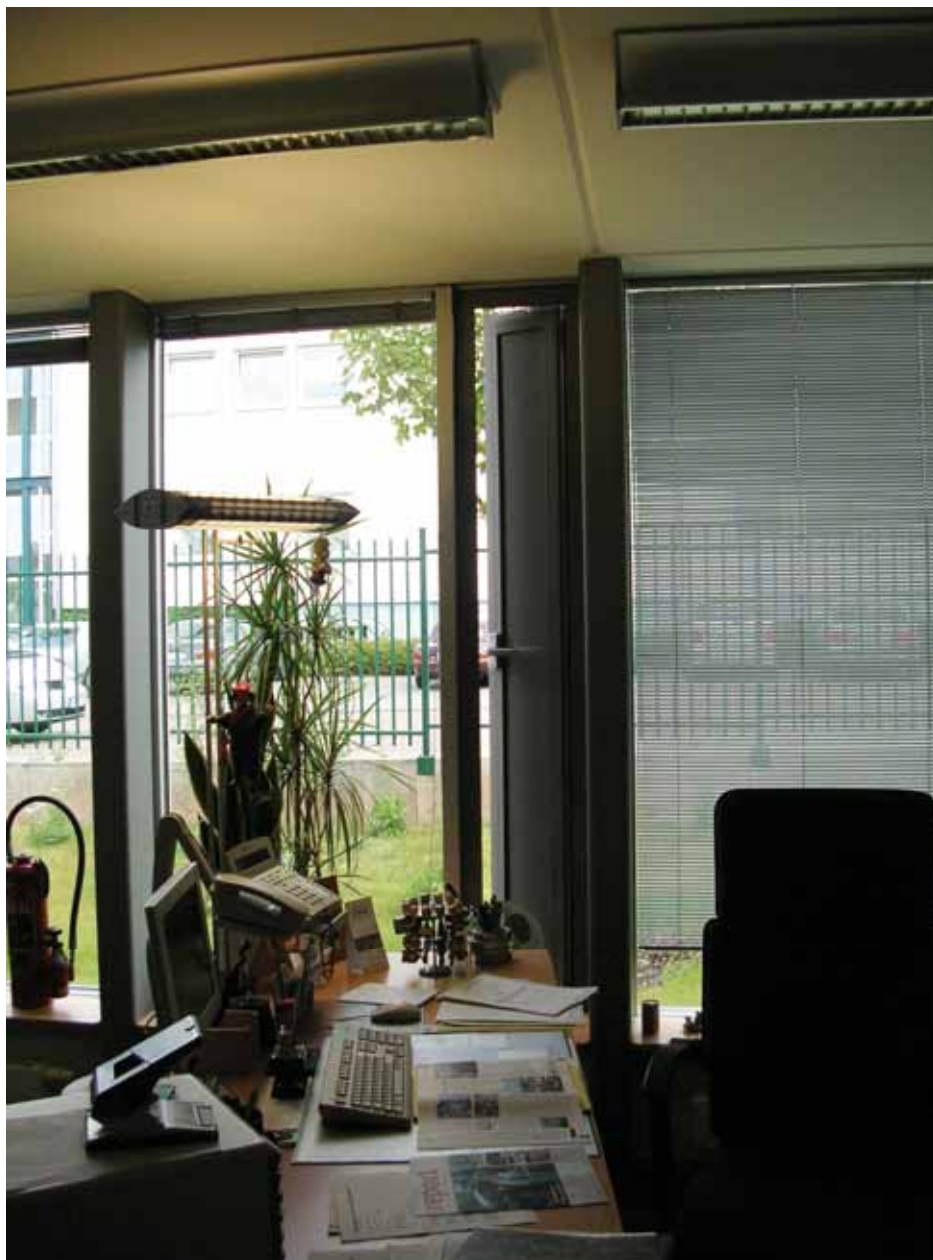
Abbildung 31-2: Unzureichender Sonnenschutz zwischen den Scheiben
