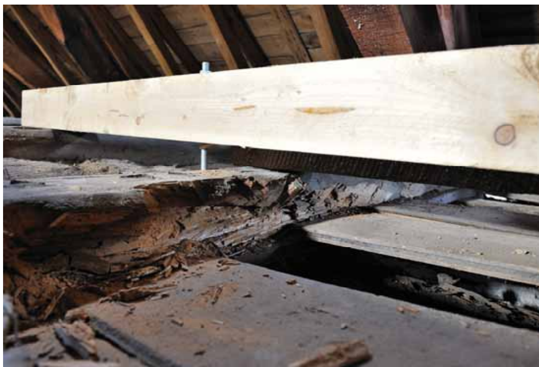
Abbildung 26-2: Sicherung Deckenkonstruktion Reithaus
