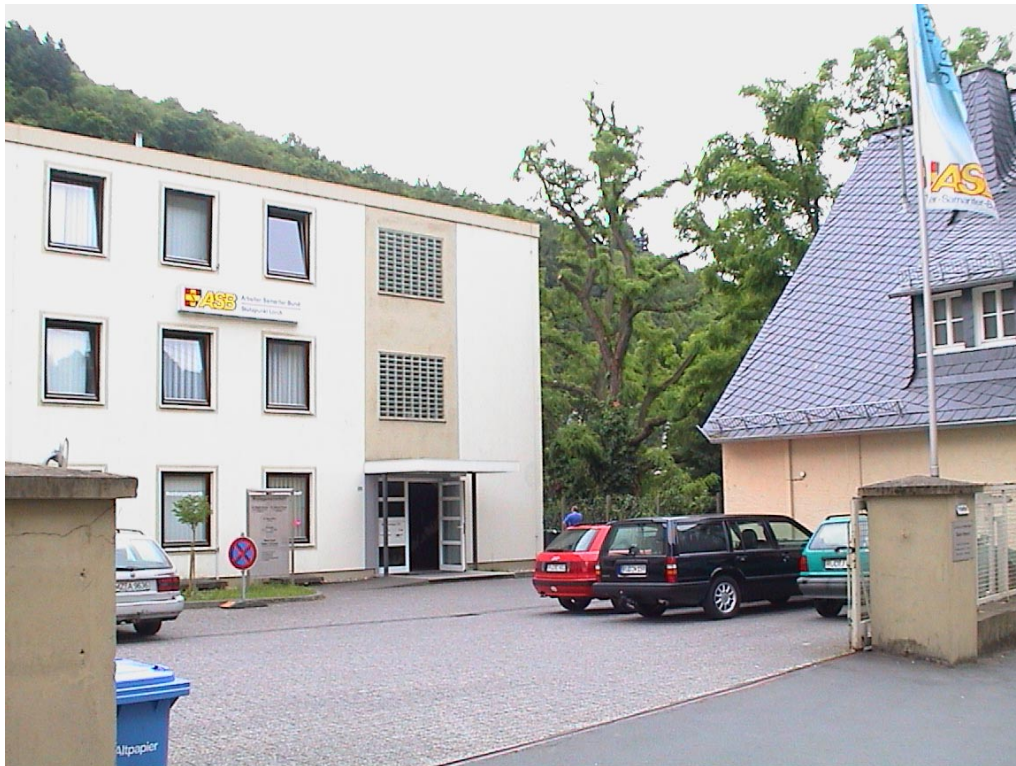
Ansicht 70: Schwieriges Ausrücken an der Rettungswache Lorch / Rhein (Rheingau-Taunus-Kreis). Aufnahme vom 5. Juni 2002.
