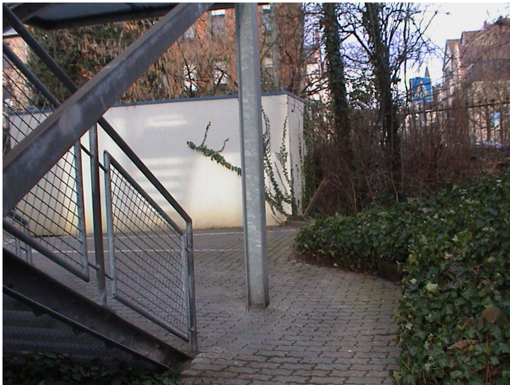
Ansicht 77: Metallpfeiler im Laufweg der Besatzung zur Garage des Notarzteinsetzfahrzeugs in Hanau (Main-Kinzig-Kreis). Aufnahme vom 23. Januar 2002.
