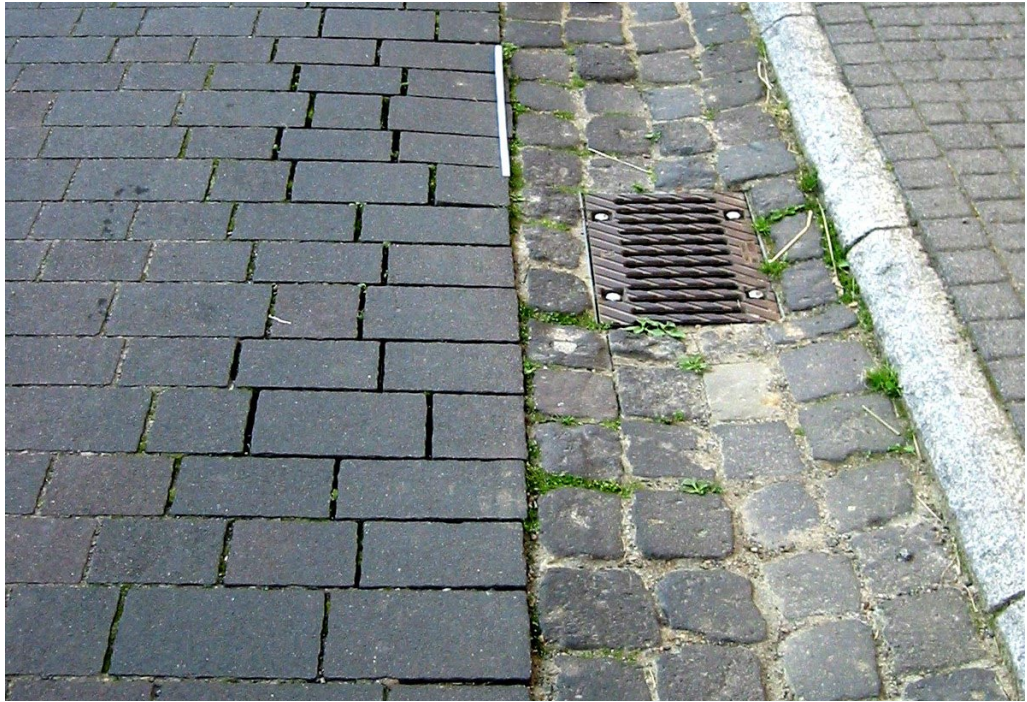
Ansicht 104: Pflasterschäden in der Ringsstraße in Neustadt (Hessen). Zur Entwässerungsrinne hin abgekipptes Pflaster. Aufnahme aus dem Jahr 2002.
