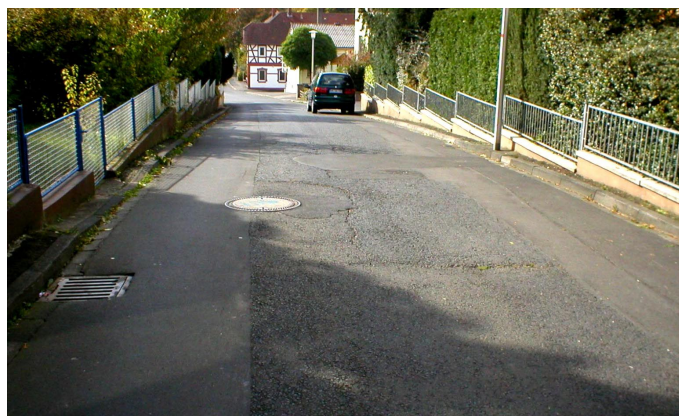
Ansicht 98: Beispiel für eine Straße der Zustandsklasse 4. Neukirchen (Knüllgebirge). Aufnahme aus dem Jahr 2002.
