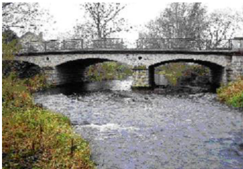
Zustandsnote 2,0 (1/ 0/ 2) Unterführung der Wehre Brücken-Nr. 4825 543 im Zuge K 34 Werra-Meißner-Kreis
