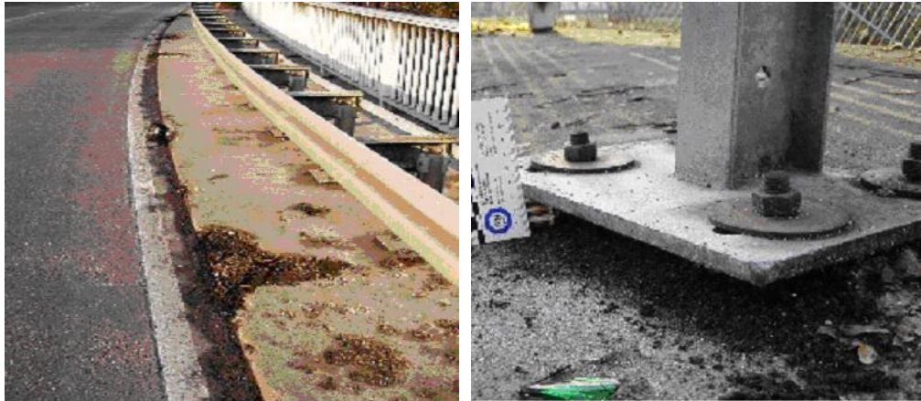
Ansicht 151: Brückenbauwerk mit noch ausreichendem Bauwerkszustand mit Zustandsnote 2,9. Odenwaldkreis. Unterführung Pirellistraße (Brückennummer 6120 514) im Zuge der K 212. Aufnahmen aus dem Jahr 2005.
