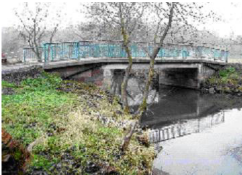
Zustandsnote 3,9 (3/ 2/ 3) Unterführung der Haune Brücken-Nr. 5224 538 im Zuge K 48 Landkreis Hersfeld-Rotenburg
