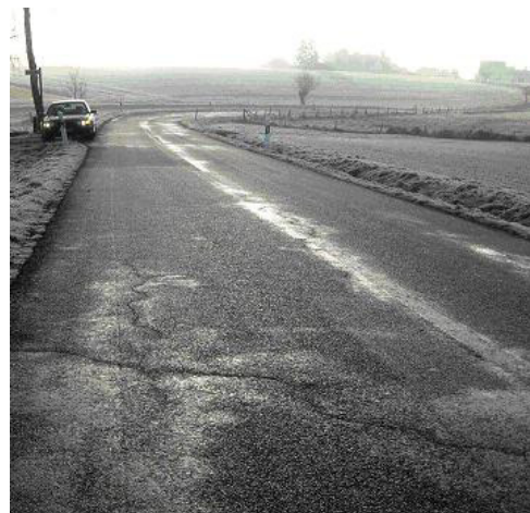
Ansicht 134: Merkmalsgruppe „Risse, offene Nähte“ mit Zustandsbewertungen 4,5. Schwalm-Eder-Kreis. K 119, Ottrau – L 3158. Aufnahme aus dem Jahr 2004.
