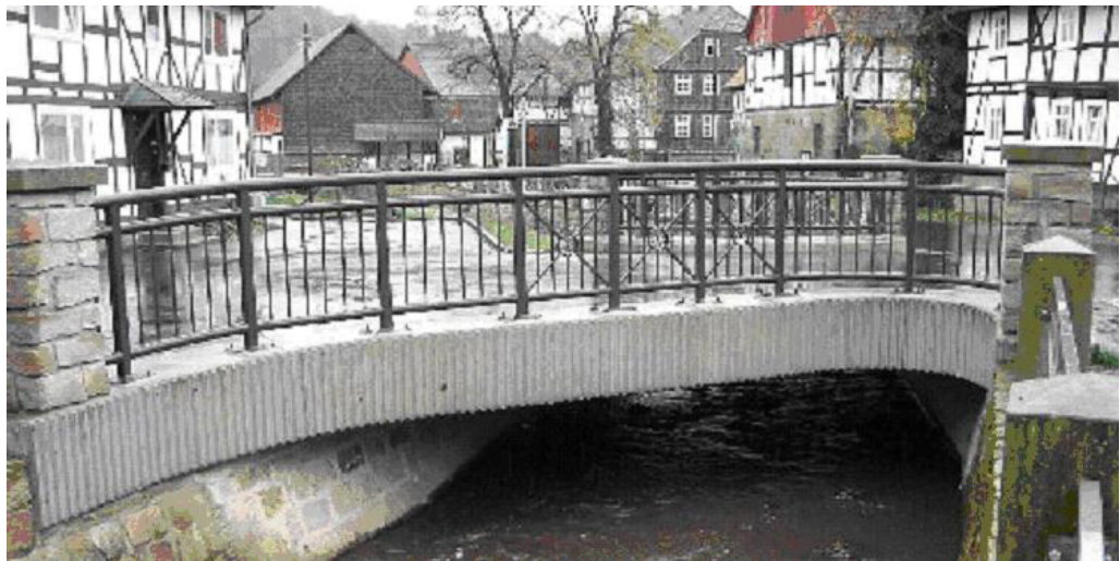
Ansicht 150: Brücke mit gutem Bauwerkszustand (Zustandsnote 1,9). Werra-Meißner-Kreis. Unterführung Rautenbach (Brückennummer 4624 831) im Zuge der K 55. Aufnahme aus dem Jahr 2004.
