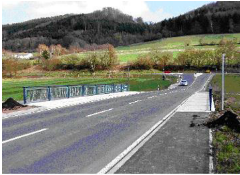
Zustandsnote 1,2 (0/ 0/ 1) 357 Unterführung Flutmulde der Eder Brücken-Nr. 4819 561 im Zuge K 85 Landkreis Waldeck-Frankenberg
