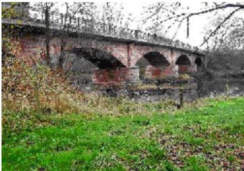
Zustandsnote 3,0 (1/ 3/ 3) Unterführung der Eder Brücken-Nr. 4822 545 im Zuge K 4 Schwalm-Eder-Kreis
