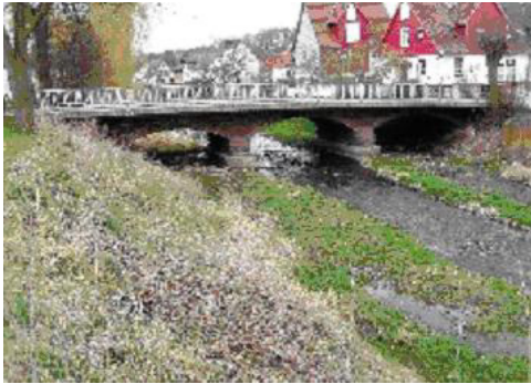
Zustandsnote 2,6 (0/ 3/ 2) Unterführung der Erpe Brücken-Nr. 4620 530 im Zuge K 11 Landkreis Waldeck-Frankenberg
