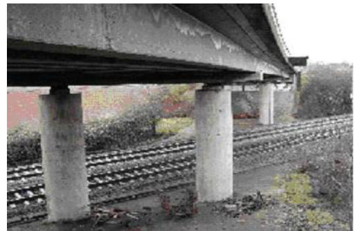
Zustandsnote 2,4 (0/ 2/ 2) Unterführung der DB AG Brücken-Nr. 5218 540 im Zuge K 59 Landkreis Marburg-Biedenkopf
