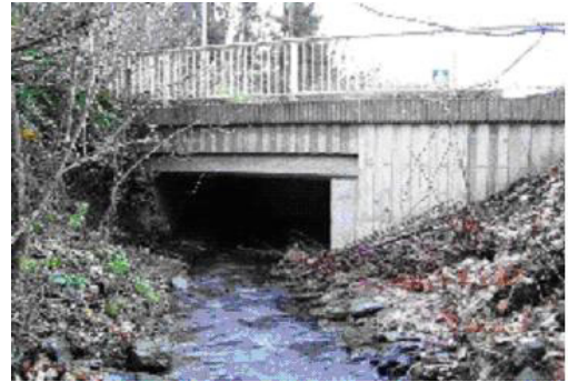
Zustandsnote 1,2 (0/ 0/ 1) Unterführung Westerbach Brücken-Nr. 5817 797 im Zuge K 769 Hochtaunuskreis
