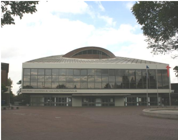
Ansicht 68: Theater in Rüsselsheim. Aufnahme vom 23. September 2011.
