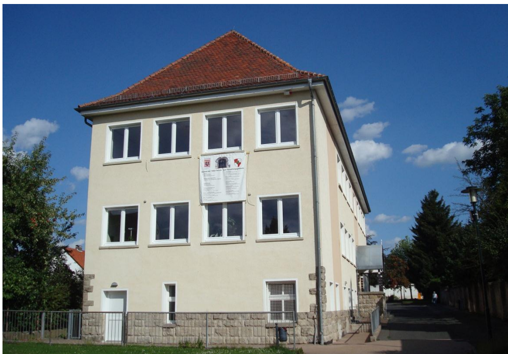
Ansicht 124: Wehretal. Ausbau der „Alten Schule“ zum Verwaltungsgebäude mit neuem Rathaus. Aufnahme vom 17. August 2011.
