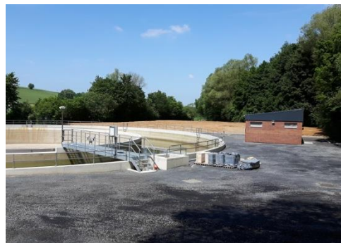
Ansicht 142: Kläranlage Esch nach dem Rückbau. Aufnahme des Abwasserverbands Emsbachtal. Juni 2016.
