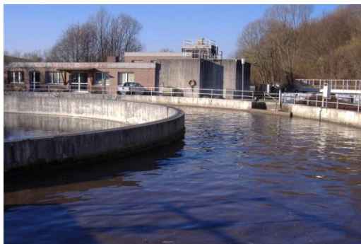
Ansicht 141: Kläranlage Esch vor dem Rückbau. Aufnahme des Abwasserverbands Emsbachtal. Juli 2015.
