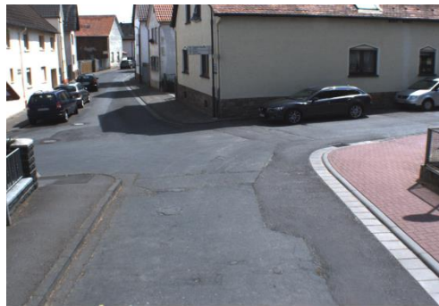
Ansicht 201: Zustandklasse 5: Haingraben Ober-Mörlen. Aufnahme vom 16. Juni 2015.
