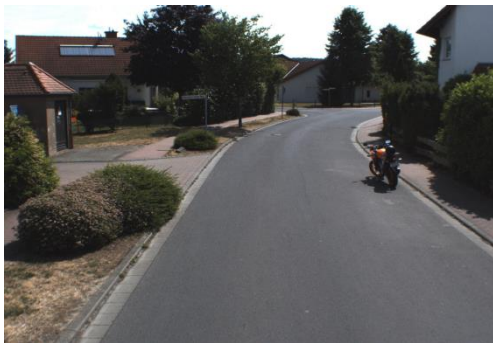
Ansicht 200: Zustandklasse 1: Dr.-Werner-Stoll-Straße Ober-Mörlen. Aufnahme vom 16. Juni 2015.
