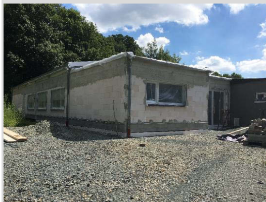
Ansicht 123: Bau eines Dorfgemeinschaftshauses in Oberwetz (Schöffengrund). Aufnahme vom 18. Juli 2016.
