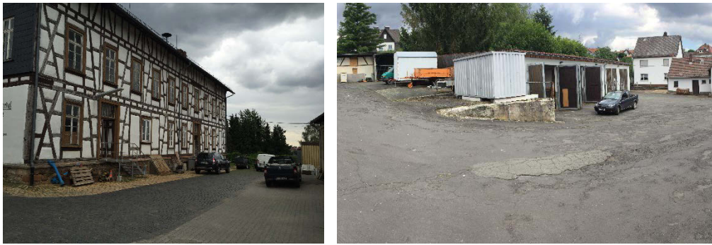
Ansicht 116: Bauhof Biebertal (historisches Hauptgebäude und separate Abstell- / Lagerfläche). Aufnahmen vom 11. Juli 2016.
