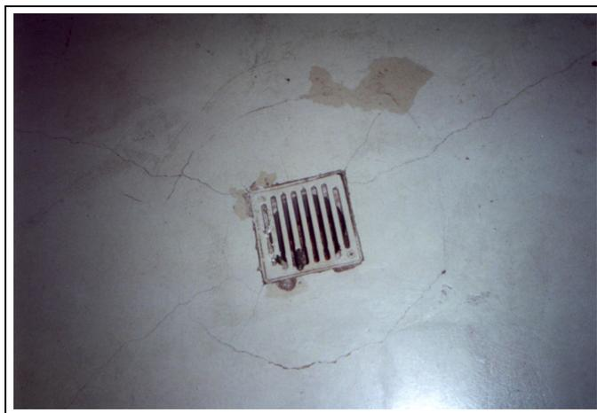
Abbildung 19-8: Informatikgebäude der FH Gießen: Risse im Estrich
