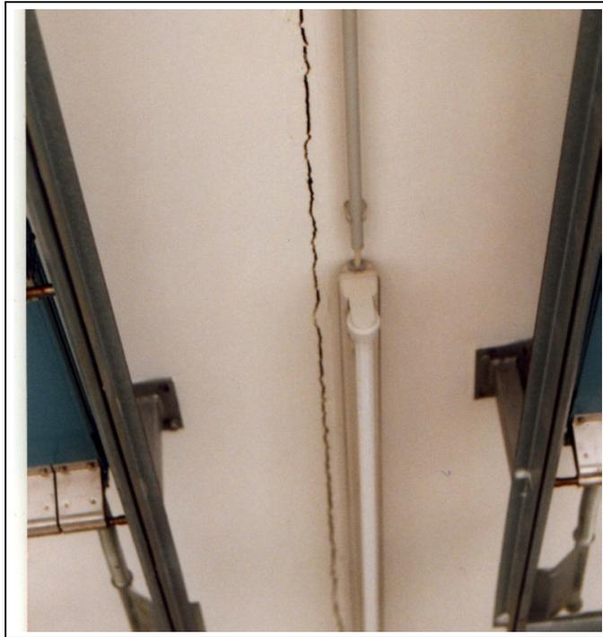
Abbildung 19-7: Polizeistation Bad Vilbel: fehlerhafte Dehnungsfuge
