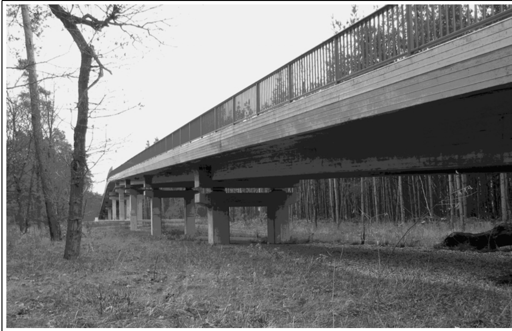
Abbildung 18-1: Überführung des Waldweges
