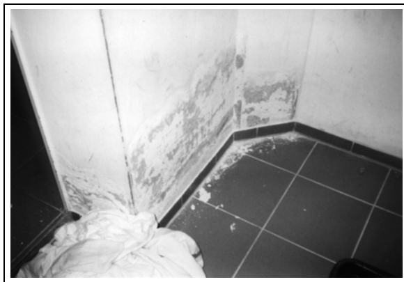
Abbildung 19-15: JVA Wiesbaden: Feuchtigkeitsmangel
