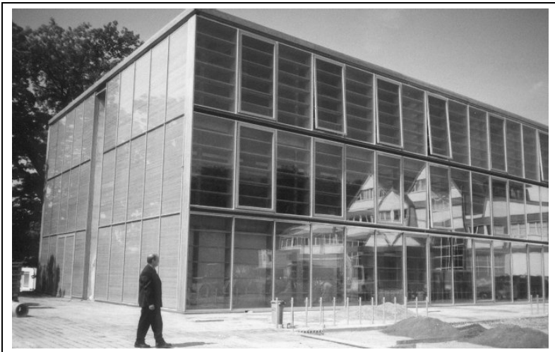
Abbildung 20-1: Neubau für den Fachbereich Gestaltung der FH Wiesbaden
