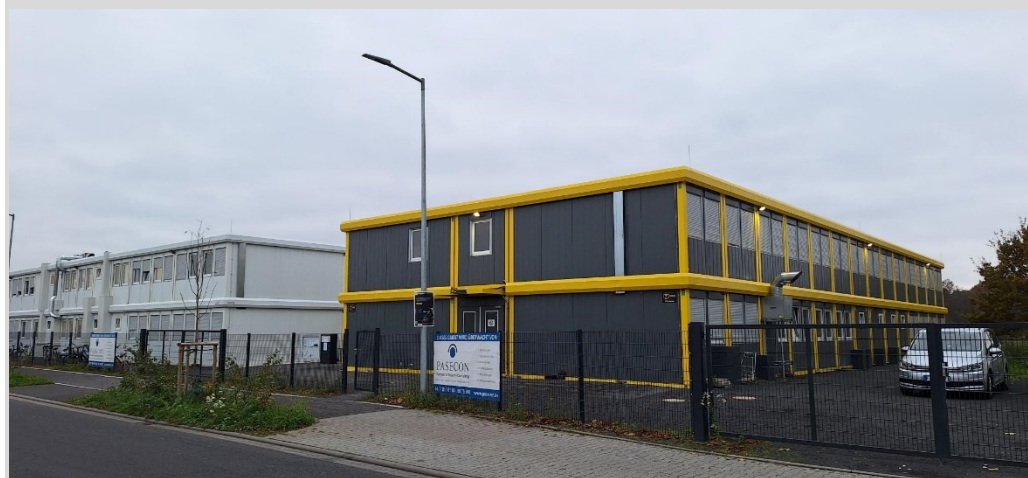
Ansicht 35: Containeranlage am Fliegerhorst (Aufnahme vom 15. November 2024)
