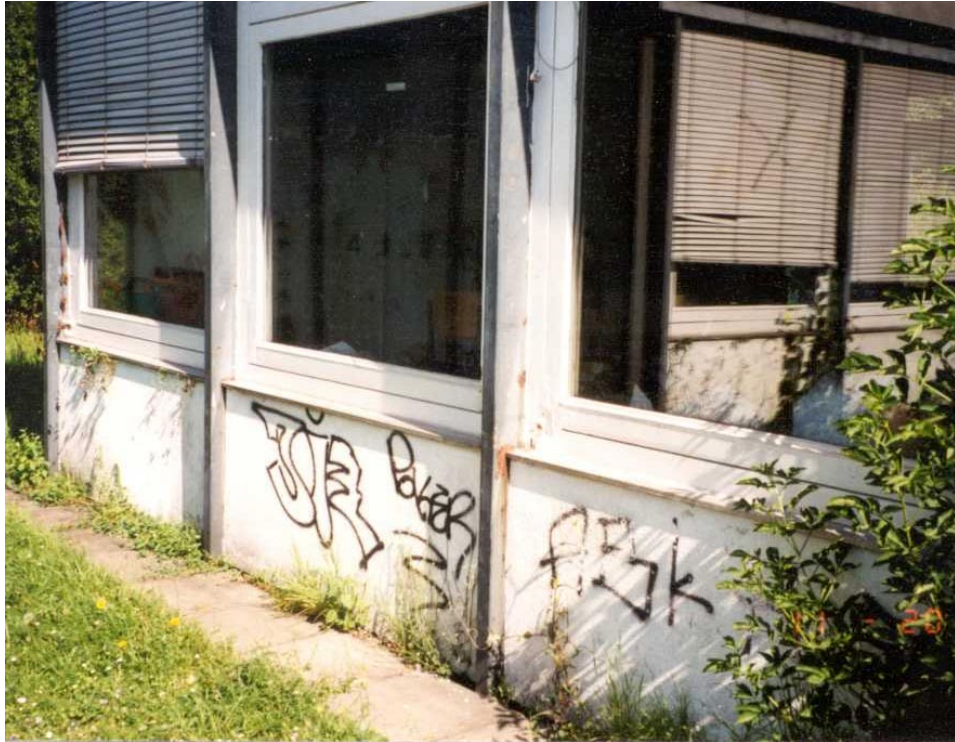
Ansicht 72: Außenfassade eines Pavillons der Theodor-Heuss-Schule, Offenbach am Main
