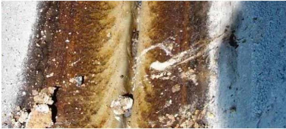
Ansicht 185: Sohlenerosion in Asbestzementrohr (2002) vor der inzwischen abgeschlossenen Sanierung. Dokumentation Abwasserverband Bracht.
