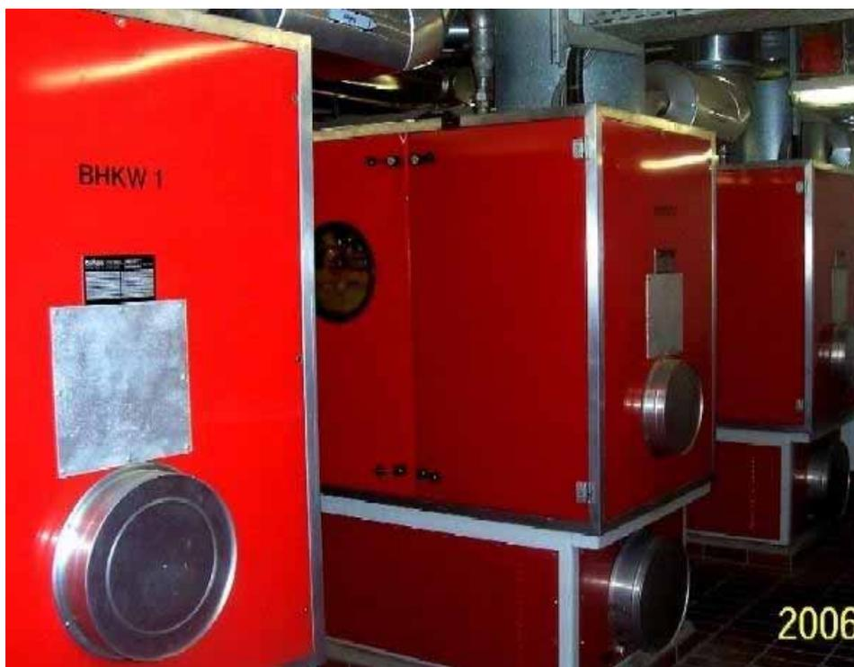
Ansicht 201: Blockheizkraftwerke des Abwasserverbands Langen / Egelsbach / Erzhausen zur Verstromung von Klärgas. Aufnahme vom 30. August 2006.
