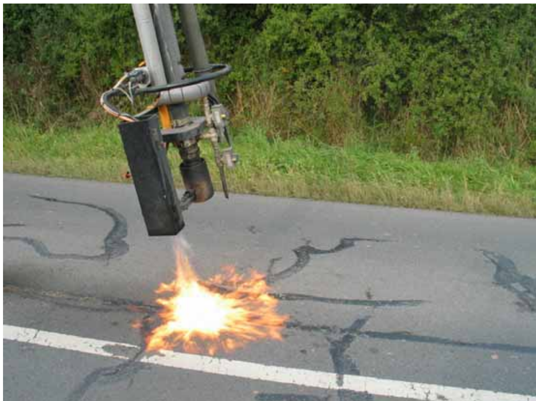
Abbildung 10-3: Patcher mit Zusatzbrenner (offene Flamme)
