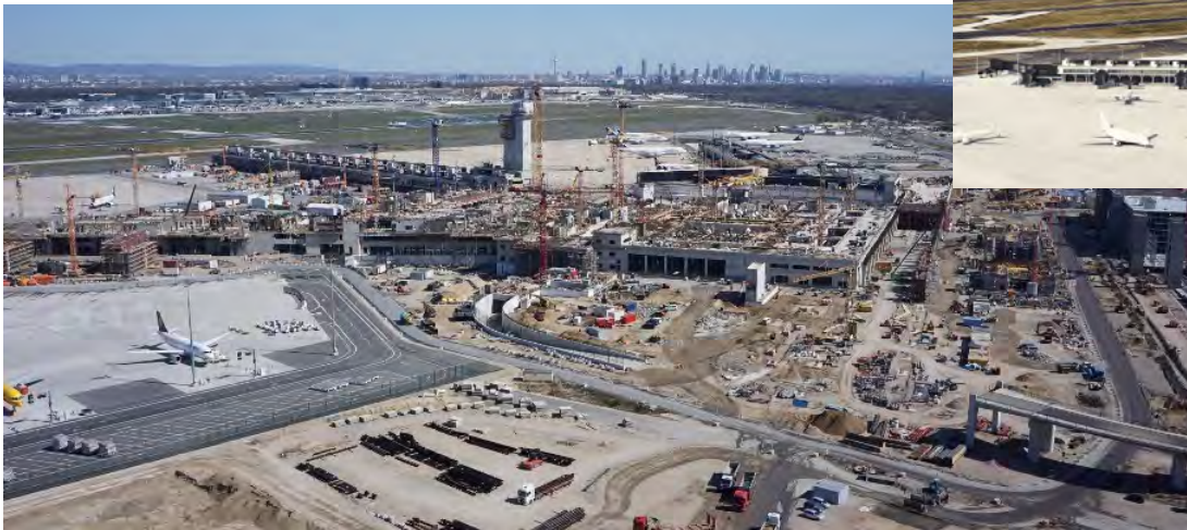
Luftbild der künftigen Terminal 3 Fläche
